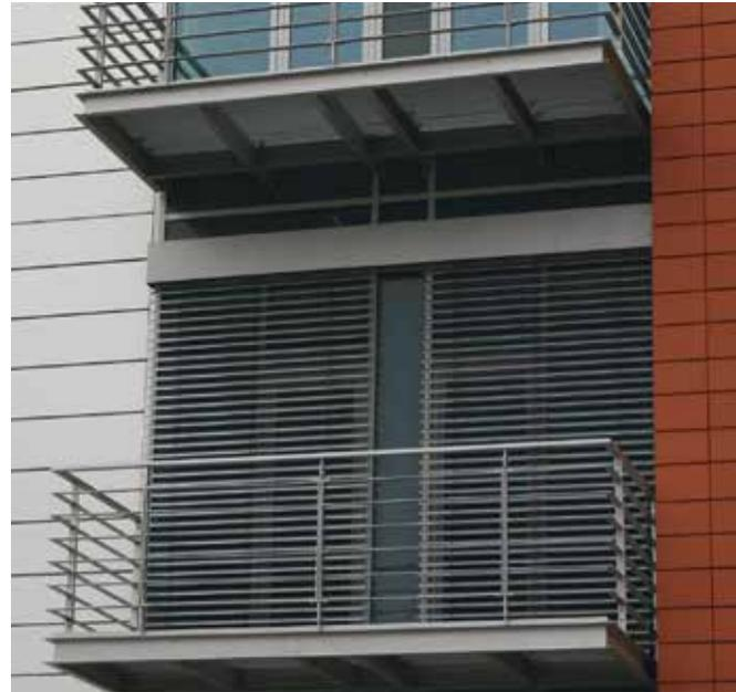
Der Raffstore mit Schienen- oder Seilführung ist mit verschiedenen Lamellentypen verfügbar. Entweder er lässt sich in den vorhandenen Schacht integrieren oder mit verschiedenen Blendenformen in der Laibung oder vor der Fassade montieren.
